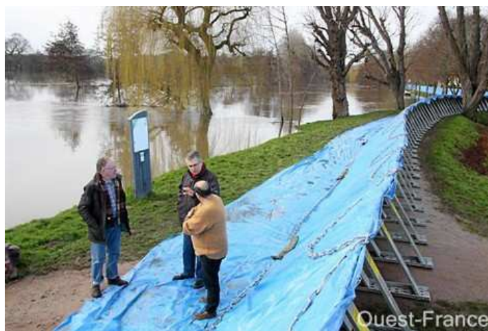
Figure 20 : Inondations de Février/Mars 2010 : Aqua-barrières à Louvigny (ouest France).
